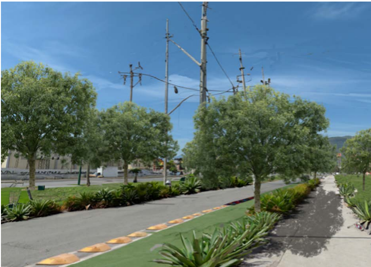
Figura 103. Antes y después: Infraestructura eléctrica. Elaboración propia. Figure 103. Before and after: Electric infrastructure. Authors' own work.
